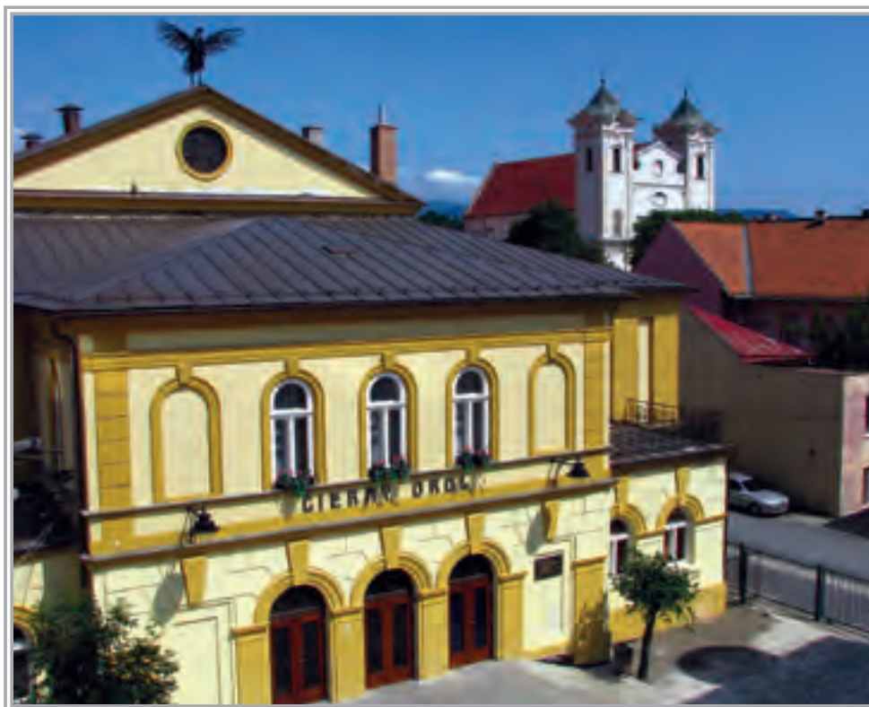
◀ 2009 – Stav strechy a objektu po rekonštrukcii.
