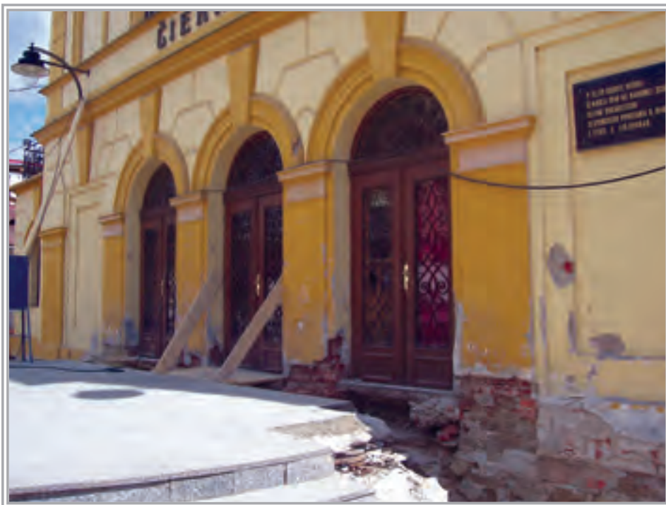
▲ 2008 – Sanácia základov objektov a obvodových múrov.
